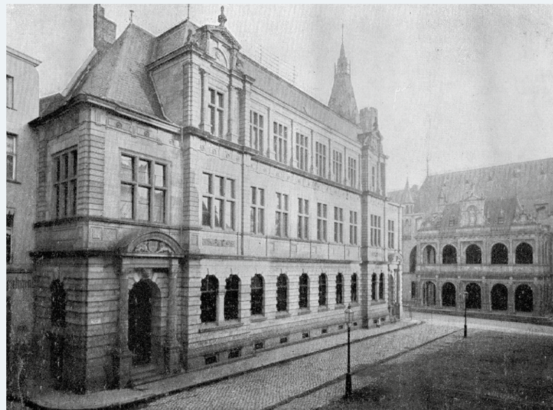
Vormalige Stadtbibliothek an der Portalgasse.
